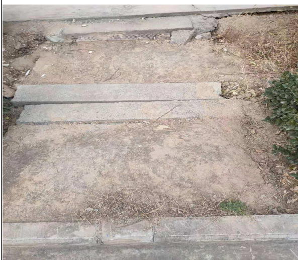
生产区化粪池
